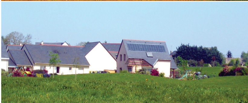
Énergie solaire individuelle Seiches-sur-le-Loir Crédit photo : aura
